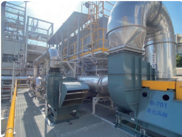
增設污染防制設備 (蓄熱式焚化爐)
