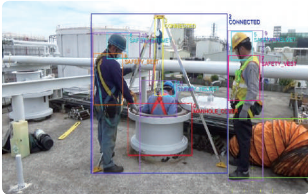
開人孔入槽局限空間作業影像辨識系統
