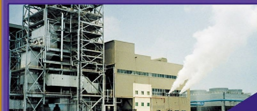
印尼吉偉化學(廠)有限公司 TK-3 PT. Pabrik Kertas Tjiwi Kimia TBK Mojokerto, Indonesia PC 300 T/H X 70 MW
