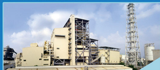
實聯化工(江蘇)公司 SCJ-1~4 Shihlien Chemical Industrial (Jiang Su) Co, Ltd Jiang Su, China CFB 300 T/H X 4
