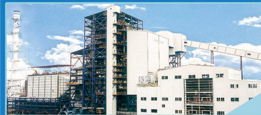
台灣汽電公司官田 TCC-KT Taiwan Cogeneration Company Tainan, Taiwan CFB 200 T/H X 49.9 MW
